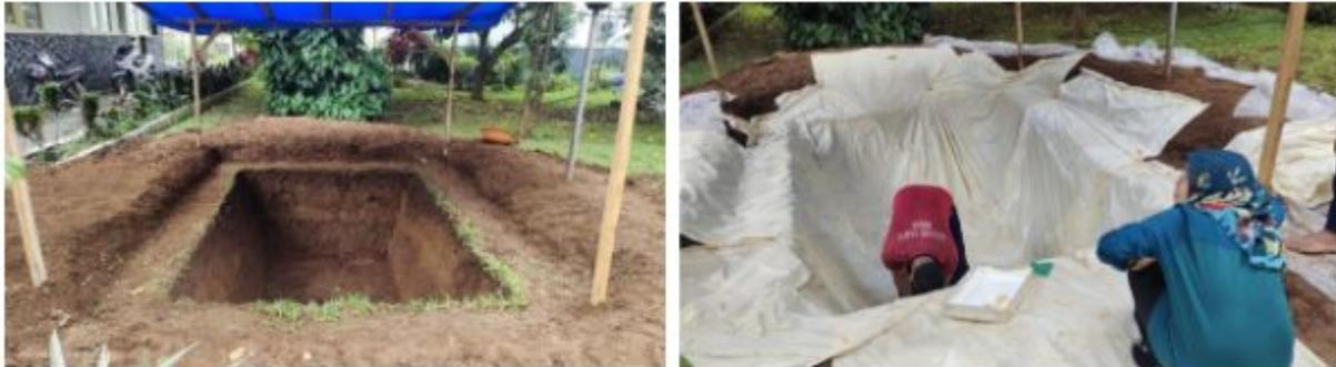
Gambar 2. Penyiapan embung dengan alas kain yang dilapisi lateks karet alam di URBG
