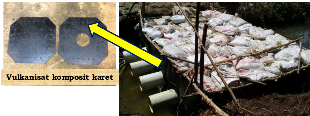
Gambar 2. Aplikasi vulkanisat komposit karet alam pada canal blocking Figure 2. Application of natural rubber composite on canal blocking
